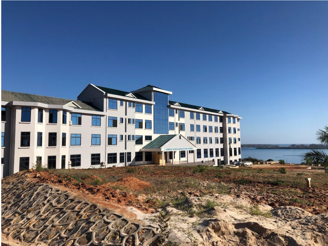
Neues Zonal Hospital für die Mtwara-Region
