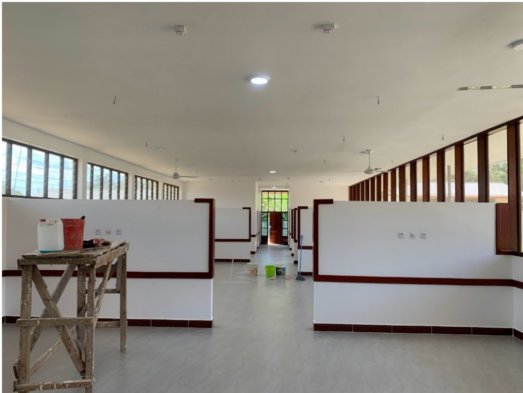
Umbau einer neuen Bettenstation in Ndanda
