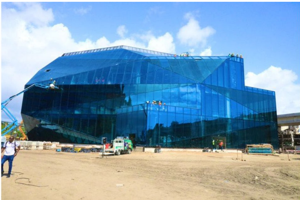
Neuer Bahnhof in Dar es Salaam im August 2022 kurz vor Fertigstellung
