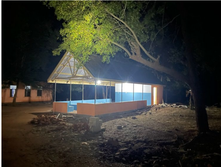
Neuer Warteraum und Sanitäranlagen
