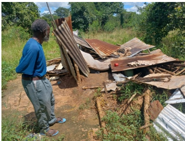
Das zerstörte Haus
